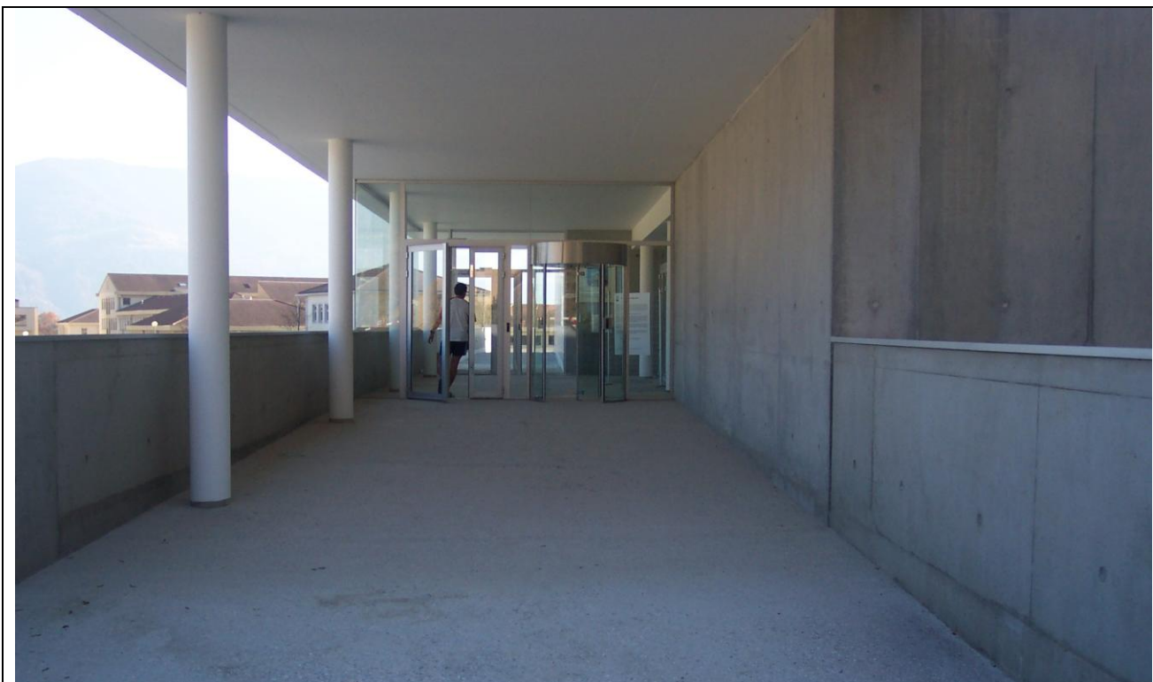
Accès au guichet d'entrée
